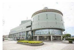
川口市鳩ヶ谷庁舎
