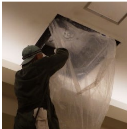
※写真は3 m天井での オーバーホール作業風景
