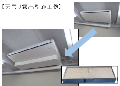
【天吊り露出型施工例】
